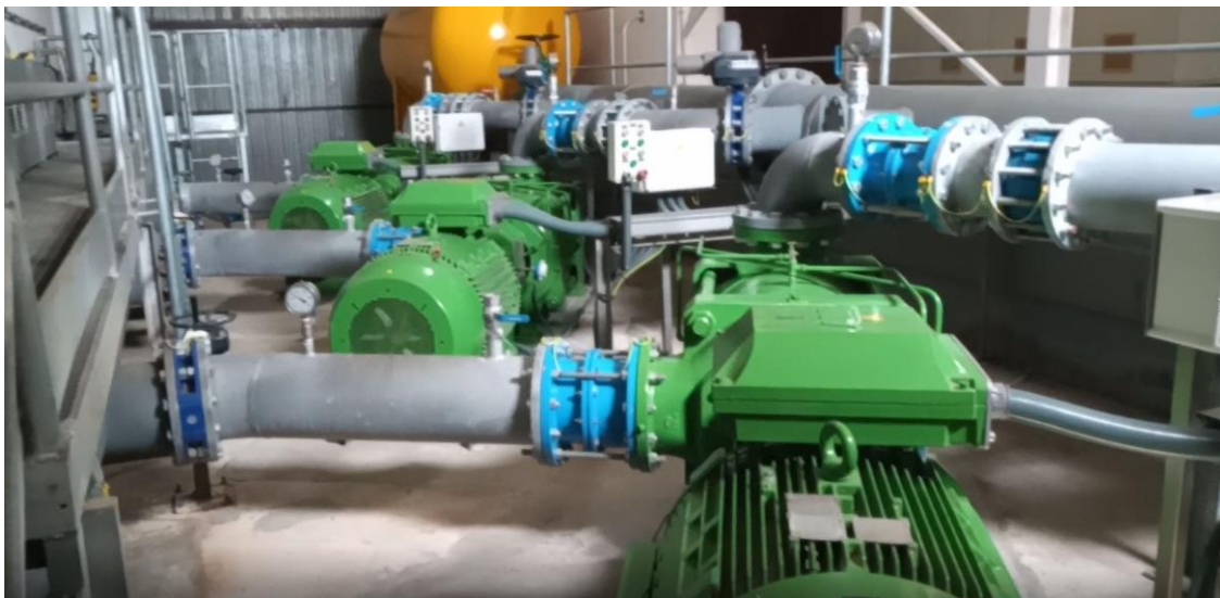
Il·lustració 1. Exemple de sala de bombes on caldrà, almenys, tres posicionats de l'escàner 3D, amb una densitat de punts de 3 mm cada 10 metres
